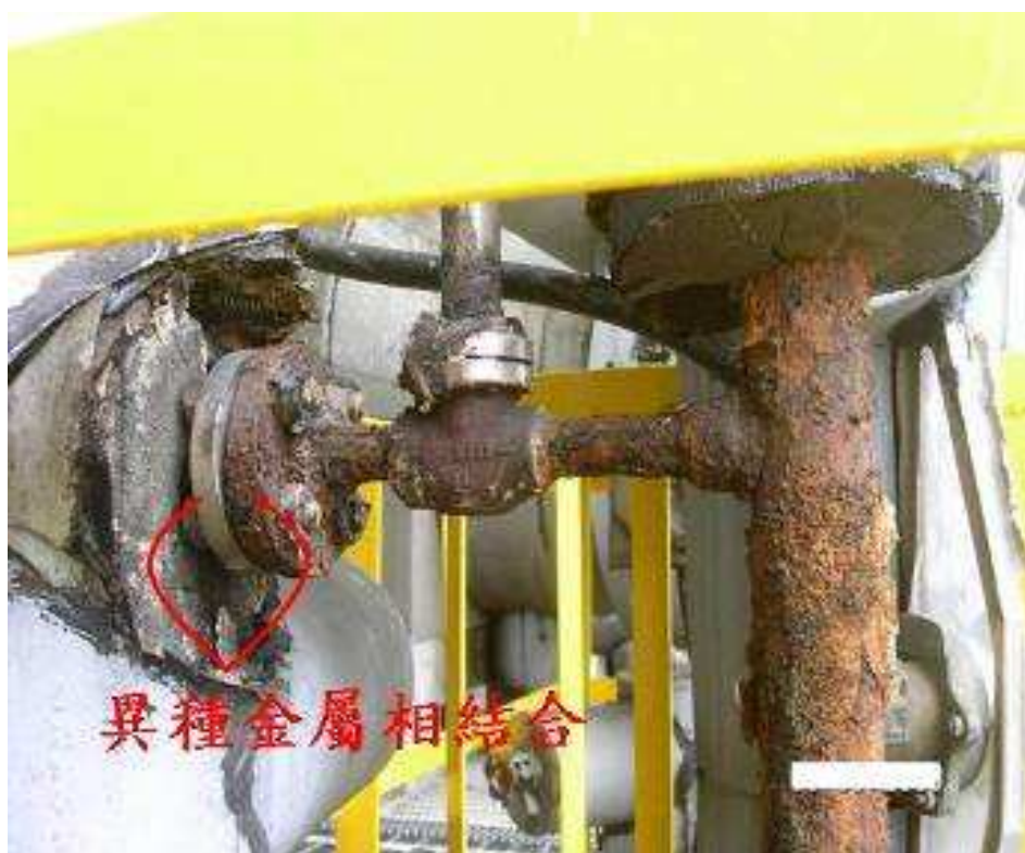
圖 8 異種金屬接合處腐蝕
